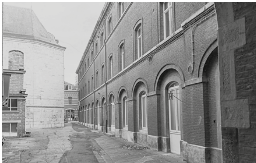
Petite aile : Ce bâtiment, situé à l'arrière de l'église, abrite pour l'instant des salles de sports.
